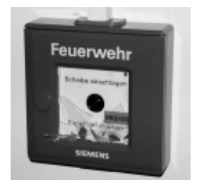
Das „Einschlagen“ des Brandmelders ist der schnellste und sicherste Weg einer Brandmeldung
